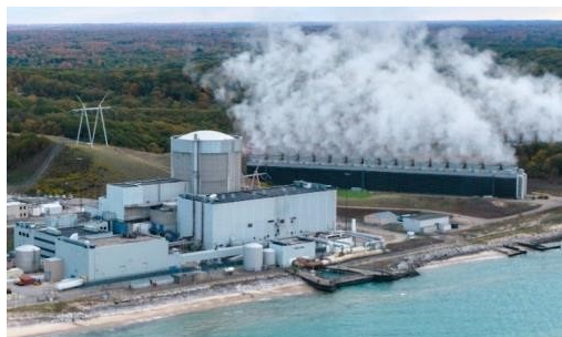
図1：パリセーズ原子力発電所
