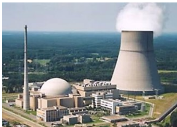
ドイツ エムスラント原子力発電所 (from WNN)
